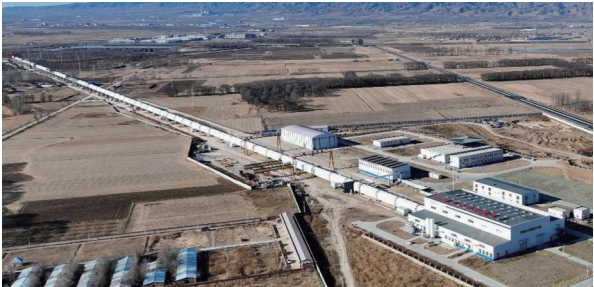
图9 低真空管道磁浮交通系统全尺寸试验线 [25]
