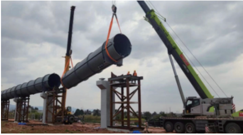
图8 正在建设的多态耦合轨道交通动模试验平台
