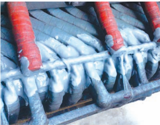
图 7 连接处涂胶改造
