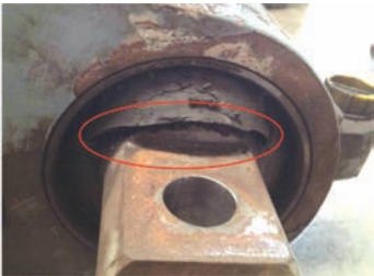
图 9 橡胶节点靠近芯轴侧的橡胶龟裂
