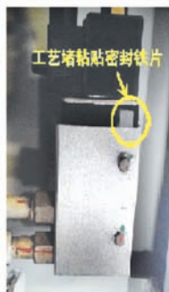
图 2 升弓电磁阀工艺堵粘贴密封铁片
