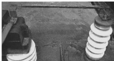
图10 加装绝缘套管
