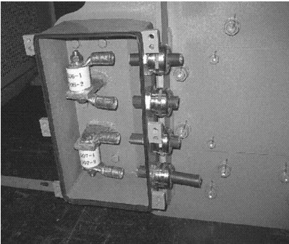
图 9 滤波电抗器接线盒密封方式 1
