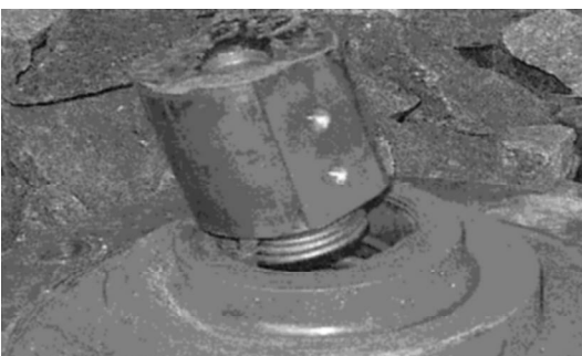
图2 故障后二位轴左侧接地装置碳刷体前端面状况
