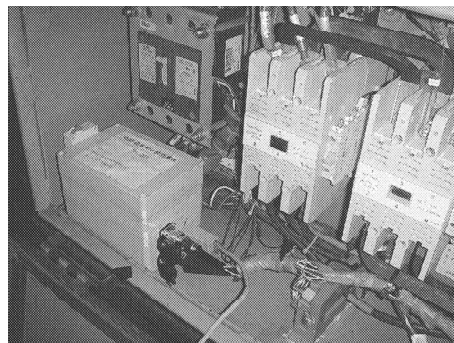
图5 检测仪安装图
