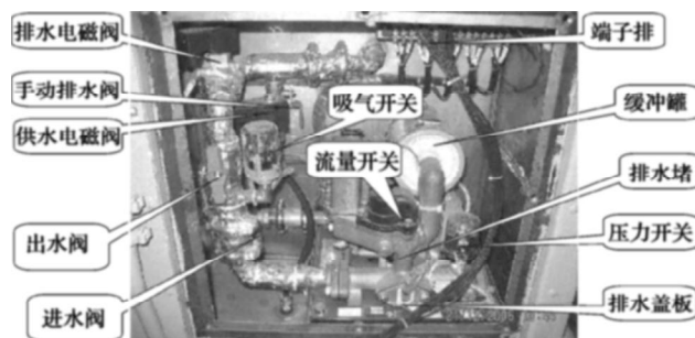
图 1 泵房内水泵系统结构组成
